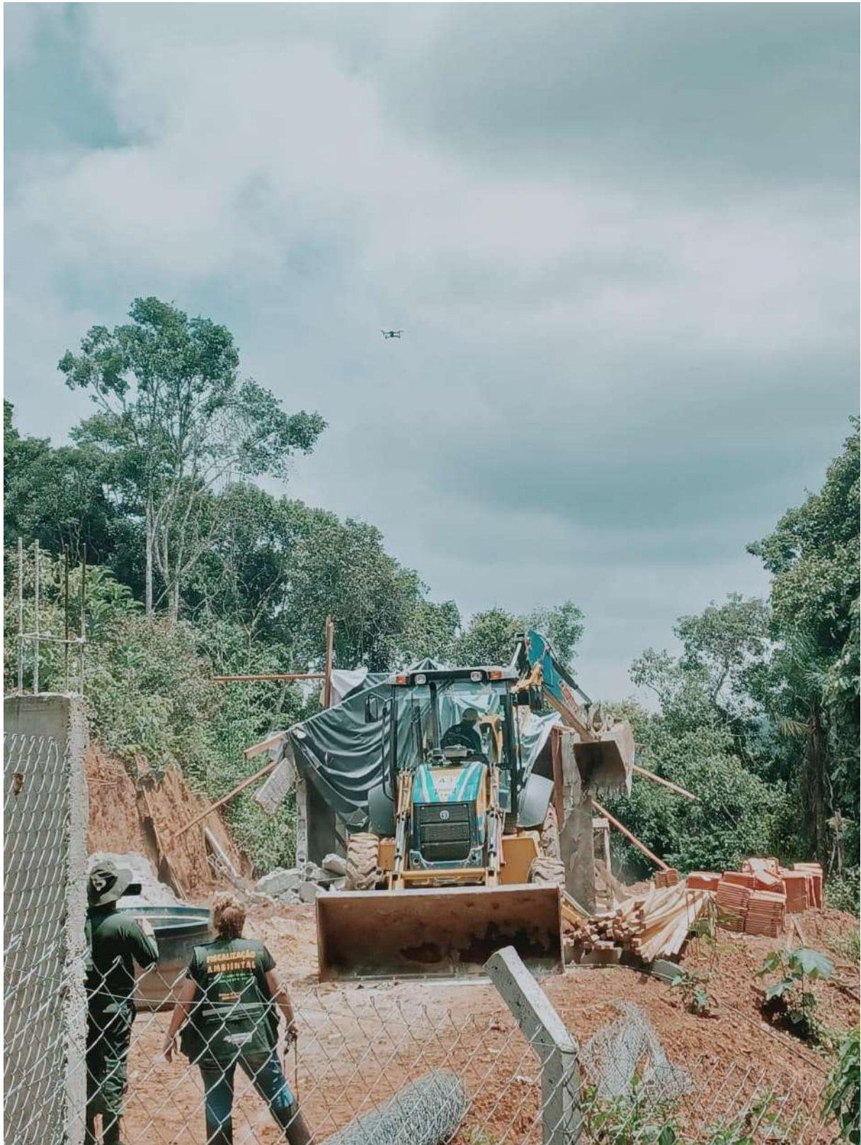
Figura 17 - Imagem da ação do desfazimento de construção irregular em Suzano
