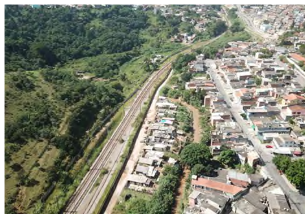
Habitação Irregular na Faixa de Domínio | Franco da Rocha - SP
