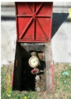
Dispositivo do Sistema de Hidrantes é encontrado normalmente em frente às edificações e é utilizado pelos bombeiros para alimentar o sistema de incêndio de uma determinada edificação, garantindo que todos os hidrantes do sistema tenham água com pressão suficiente para combater as chamas. Esse sistema pode também ser utilizado para abastecer as próprias viaturas do Corpo de Bombeiros no caso de não existirem hidrantes de solo nas proximidades.
