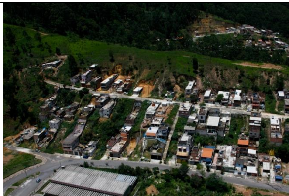
CAI-07 aspecto geral da área.
