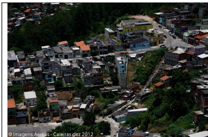
CAI-10-2 setor de médio risco, ver escada entre as ruas que definem o setor da encosta analisado.
