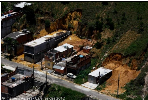
Taludes de corte com processo erosivo instalados e ausência de sistema de drenagem.
