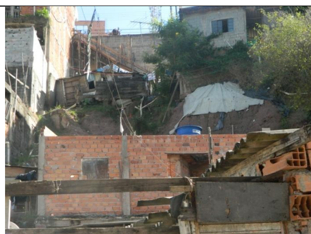
Escorregamento comprometendo imóveis a montante e jusante, necessita correção imediata.
