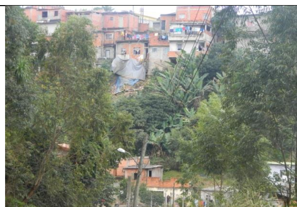
Lona Plástica em escorregamento na base do imóvel, obra localizada e urgente o plástico cria fluxo difuso da água.
