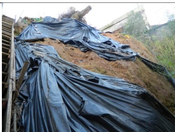
Detalhe onde podemos ver estrutura de alvenaria de imóvel parcialmente demolido, que ainda oferece risco para casa a jusante. Demolição emergencial e urgente.
