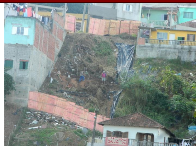
Detalhe da intervenção na área com início de talude de corte, não recomendado ao local.
