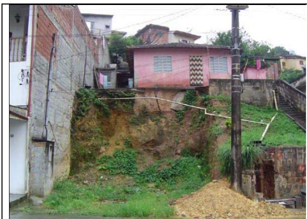
CAI-14 em 2005 após ruptura do talude frontal pondo o imóvel em risco alto.
