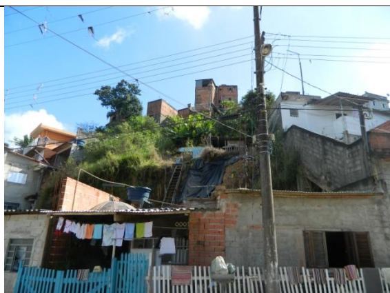
Lona plástica em escorregamento que levou a desocupação de imóvel precário a montante, o qual punha em risco o imóvel a jusante
