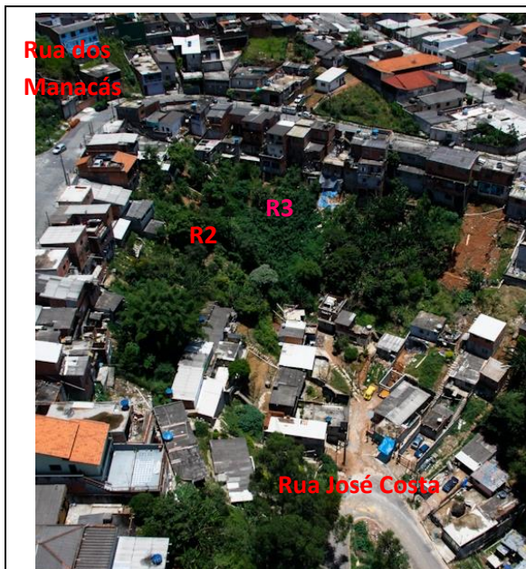
Aspecto do anfiteatro entre as Ruas José Costa e Manacás com os riscos Alto-R3 e Médio-R2.
