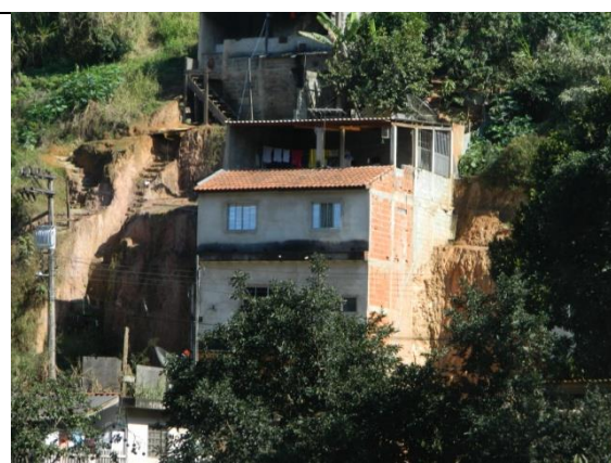
Detalhe dos taludes de corte de altura excessiva, comprometendo acesso a montante e estabilidade geral da encosta.
