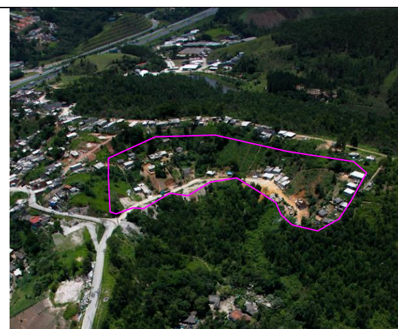
CAI-03-3 setor com grandes cortes de taludes e aterros ao longo do acesso.
