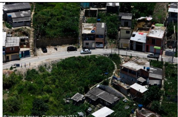
Aspecto do risco alto CAI-03-1, cortes abruptos e associados a acessos, necessidade de disciplinar o escoamento superficial com a acessibilidade.
