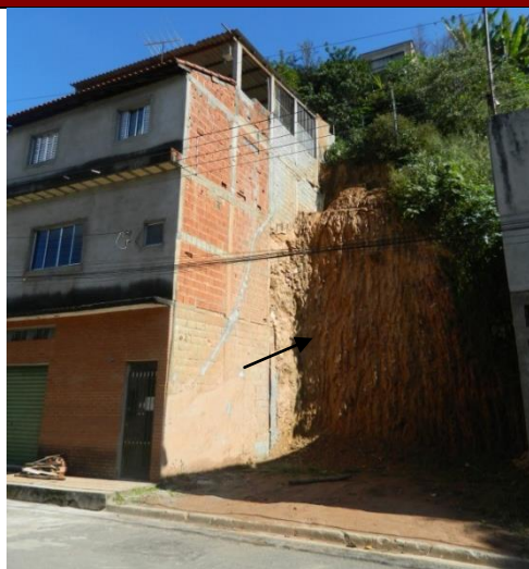
Observar como caixa da construção se insere como arrimo na encosta.
