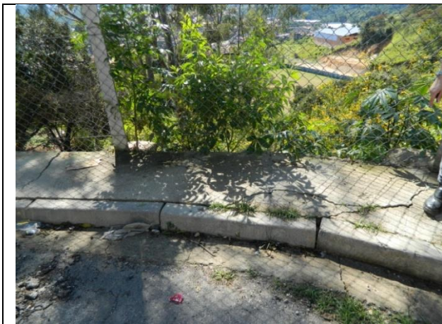
Calçada e viário em corpo de aterro, trincados por rastejo, final da Rua Lazia Franco de Camargo, eliminar infiltração das águas recuperando viário.
