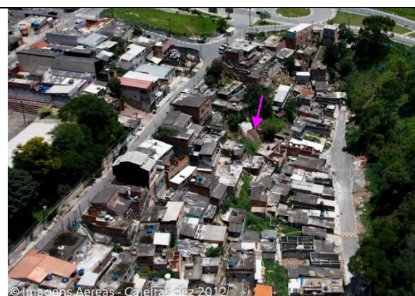
Indicação de escorregamento, setor necessita de obras de contenção localizadas e condução das águas.
