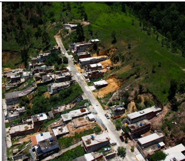
Taludes de corte e aterro,, no setor mais a montante com processos erosivos em desenvolvimento.
