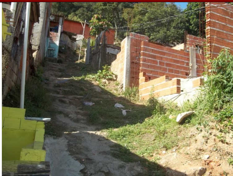
Precariedade do acesso que concentra águas e deve ser melhorado.
