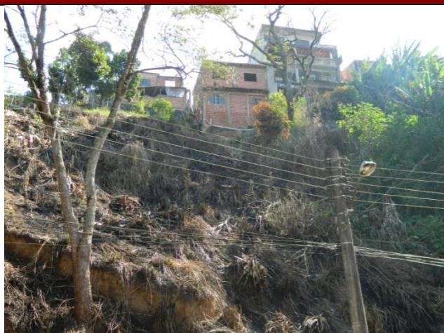
Feição erosiva instalada em antigo escorregamento expondo base do imóvel em CAI-10-1.
