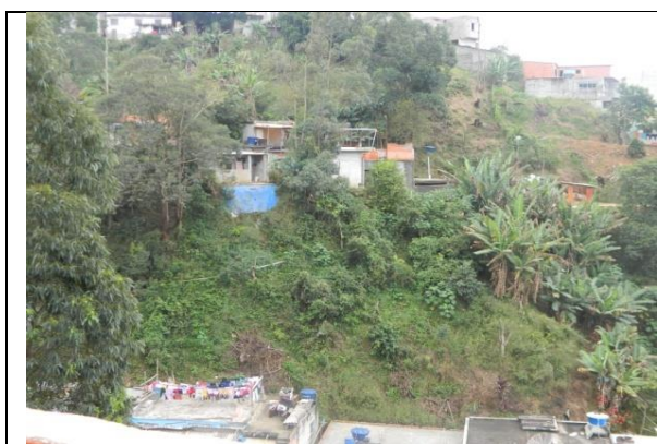
Casas na meia encosta, risco de montante e para jusante na Rua José Costa, cultivo de bananeira, CAI-01-1.
