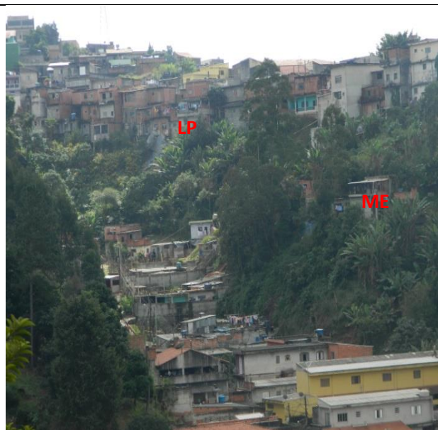
Área de alto risco CAI-01-1, indicado casa meia encosta - ME à direita e lona plástica - LP à esquerda em cicatriz de escorregamento.
