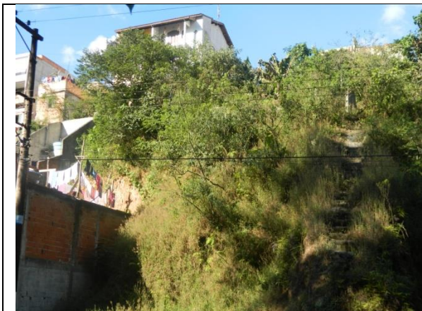
CAI-11 com taludes de corte e escada que conduzia a imóvel demolido por risco.
