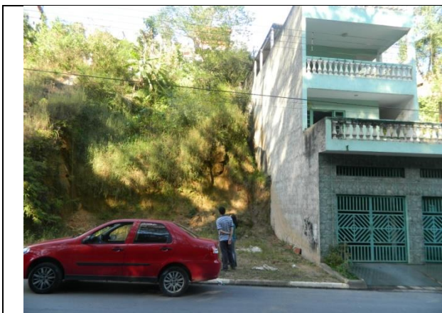
Talude de corte vertical em filito indicando condição desfavorável a estabilidade.
