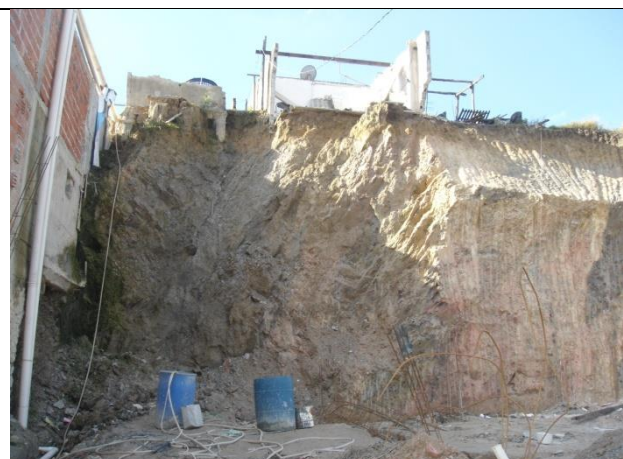
Imóvel demolido em topo de talude de corte vertical em CAI-03-1.
