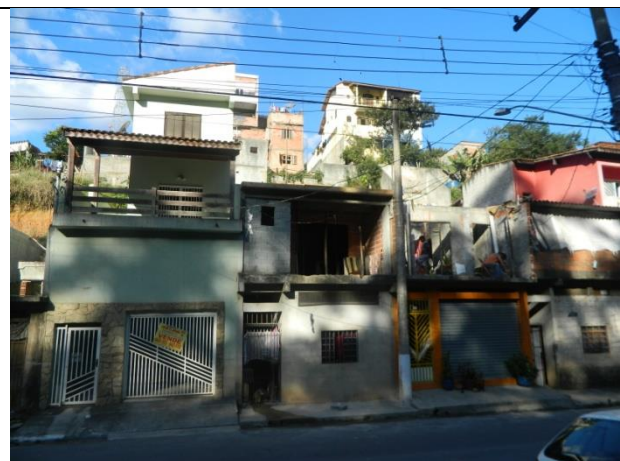
Imóveis de boa qualidade que em alguns casos já formam situação estáveis para jusante e montante.
