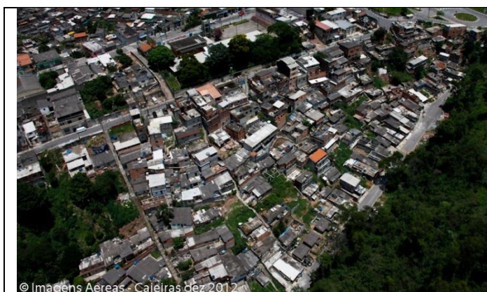
Alto risco CAI-04-1, cortes, aterros, escoamento difuso e se observam estruturas comprometidas.
