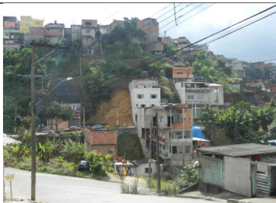
CAI-10-1 de alto risco e cortes de geometria imprópria, que devem ser coibidos e evitados, com fiscalização.
