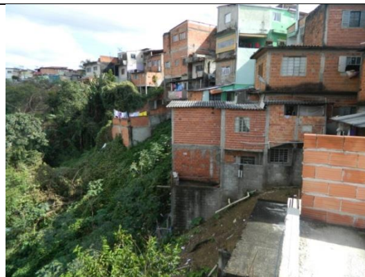
Aspecto da continuação do setor CAI-10-1, com vista dos imóveis situados a montante da encosta, onde podemos perceber aterros.
