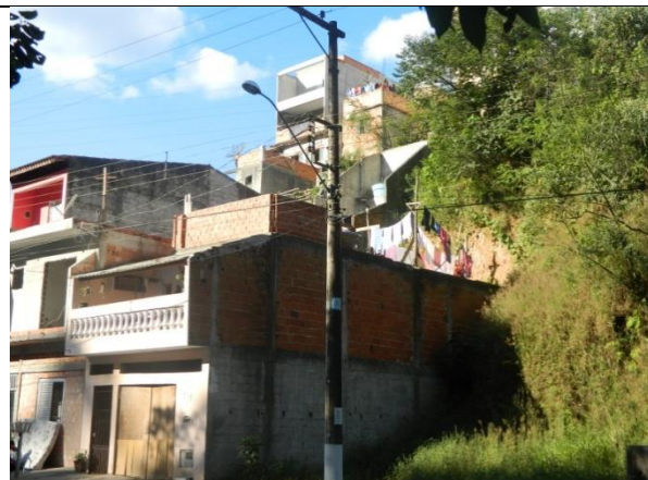
Taludes de corte em solo ainda exposto e com contenções de alvenaria na divisa.
