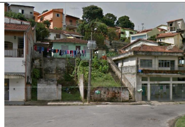
CAI-14 atualmente com muro de arrimo construído, passando o imóvel para risco baixo.
