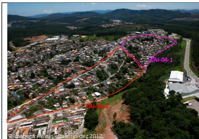
Sector de risco médio CAI-04-2 em primeiro plano e ao fundo risco alto CAI-04-1.
