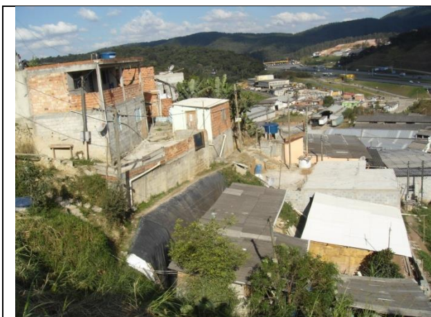
Acessos estreitos conjugados aos taludes de corte, importante disciplinar as águas nas bermas e também aquelas dos telhados no CAI-03-1.
