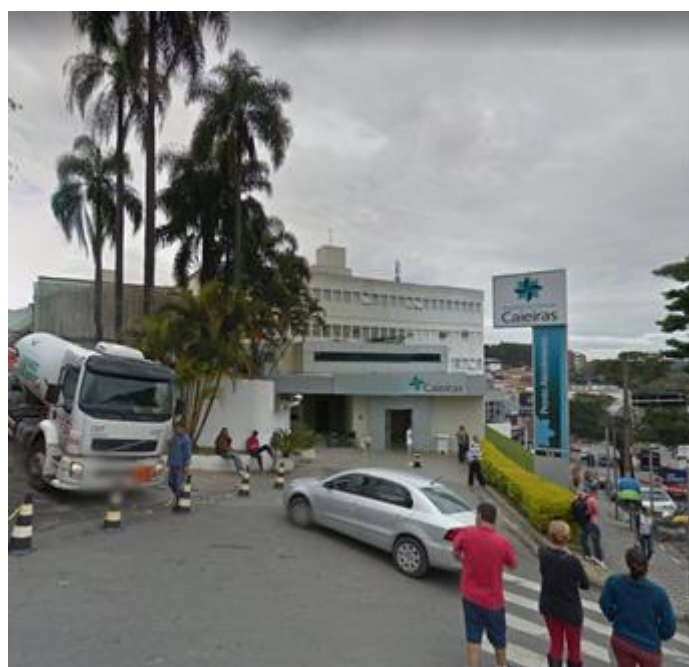
Figura 112.Hospital das Clínicas de Caieiras
